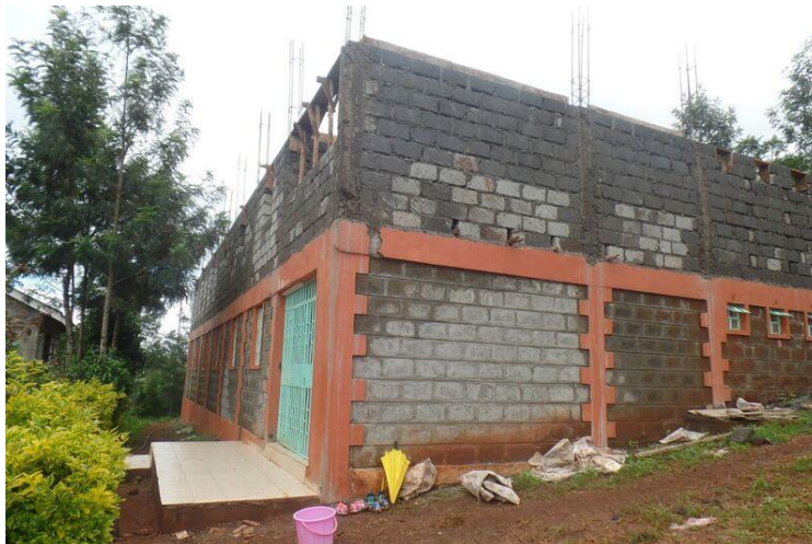
Våning 2 under pågående byggnation.
