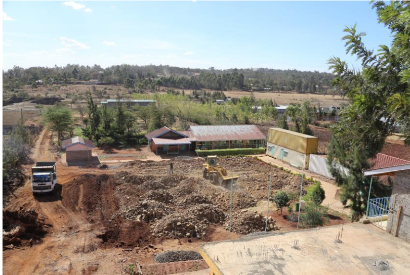
Bygget av multi-court på gång.
